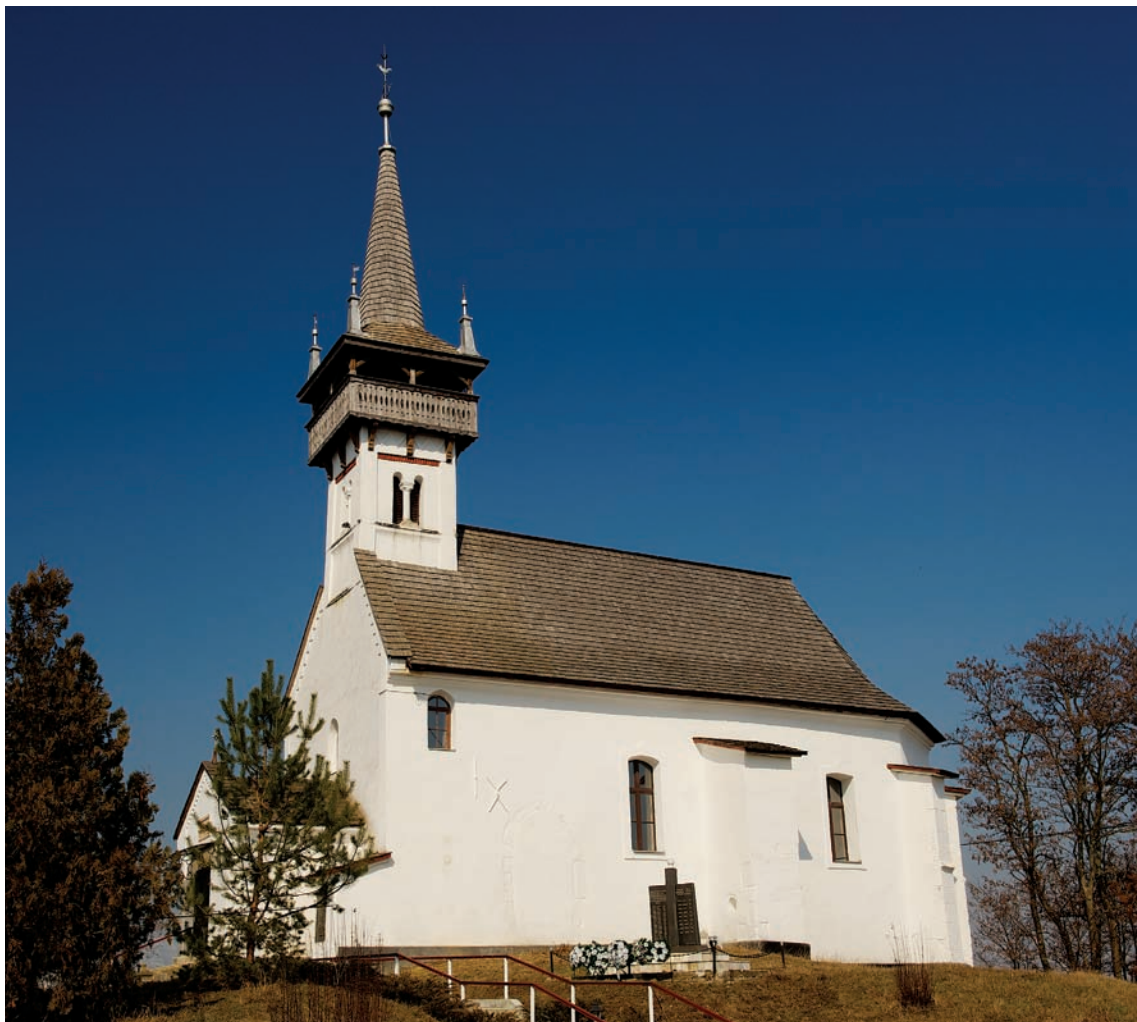
1. Загальний вид церкви з південно-західної сторони
