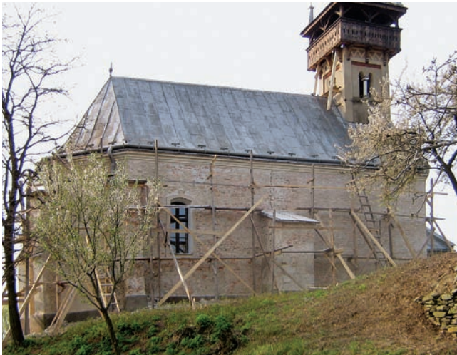
3. Північний фасад церкви під час дослідження
