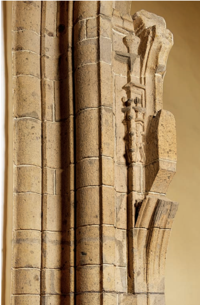
17. П'ята лекторіуму на південній опорі тріумфальної арки
