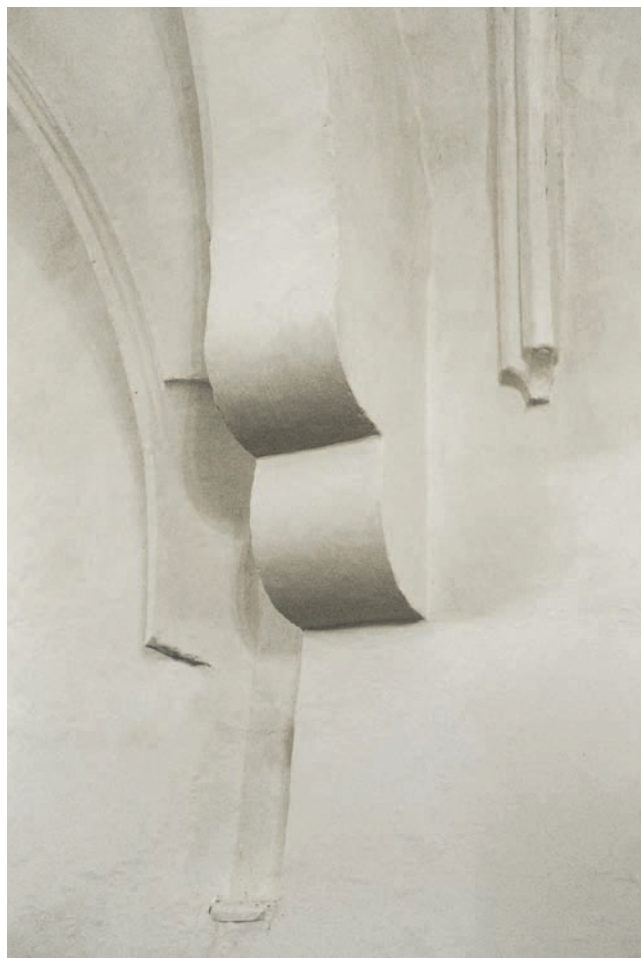
7. Фрагмент триумфальної арки та п'ят нервюр на північній стіні церкви
