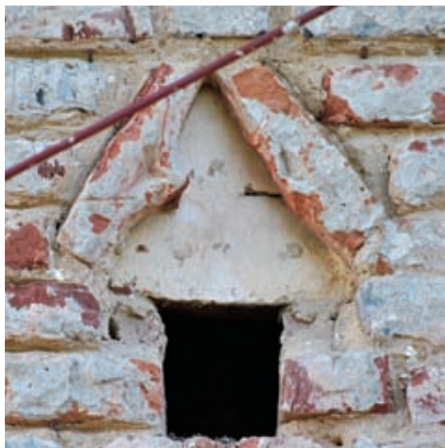
5. A templom északi oldalának falkorona alatti idomtéglaí
